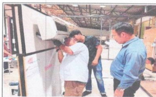
ติดตั้งเครื่องปรับอากาศแบบติด ผนังขนาด 9,000 BTU/hr.
